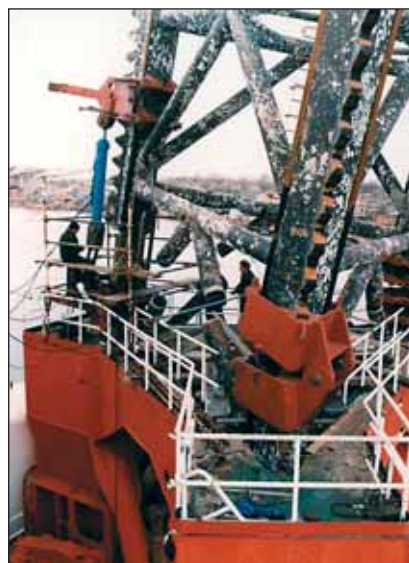
Слева — наращивание опорных колонн СПБУ «Астра» на заводе «Красные баррикады» методом опрокидывания. В наклонном положении колонну удерживает плавкран «Богатырь-3» грузоподъемностью 300 т. Справа — узел стыковки с замками и гидроцилиндром, с помощью которого верхняя часть колонны переводится в вертикальное положение
