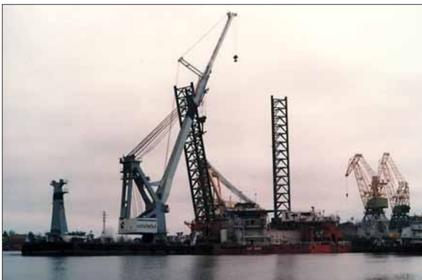
Слева — наращивание опорных колонн СПБУ «Астра» на заводе «Красные баррикады» методом опрокидывания. В наклонном положении колонну удерживает плавкран «Богатырь-3» грузоподъемностью 300 т. Справа — узел стыковки с замками и гидроцилиндром, с помощью которого верхняя часть колонны переводится в вертикальное положение
