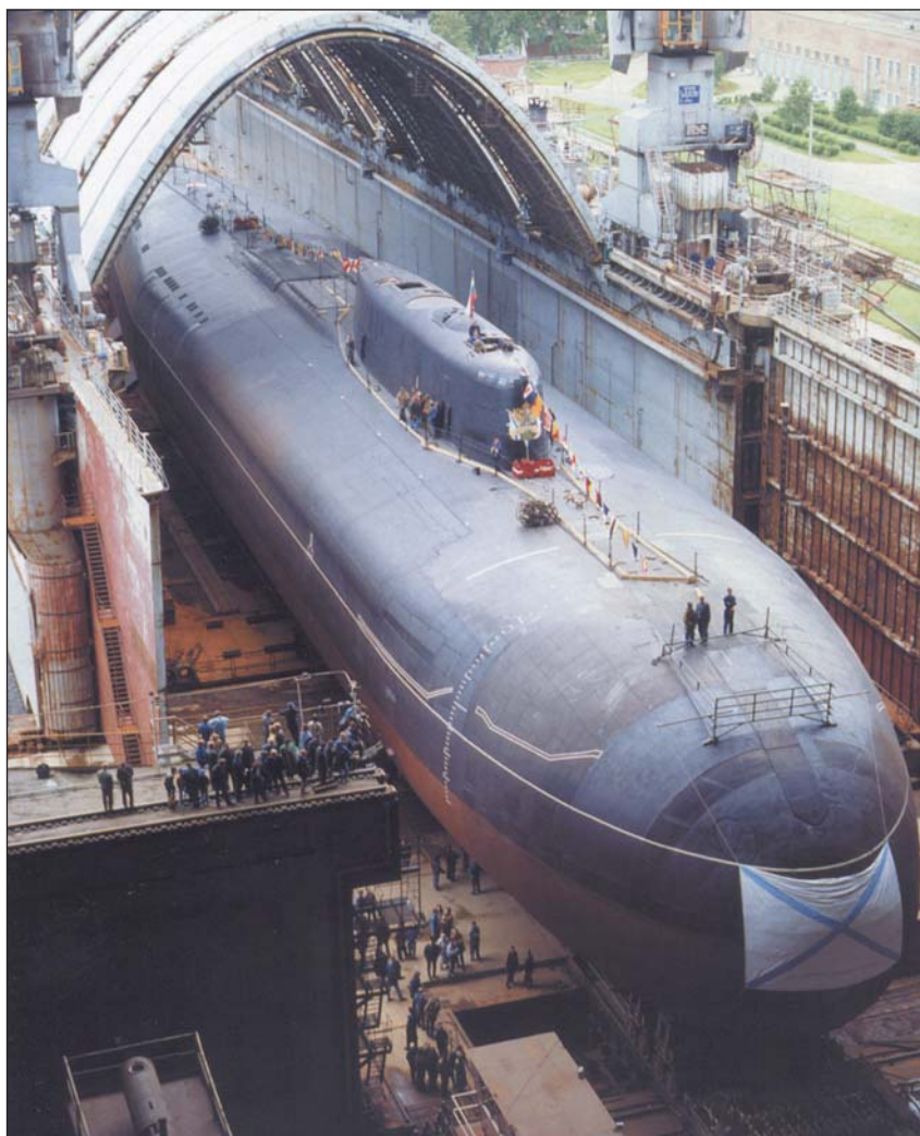
Вывод АПЛ из цеха «Севмаша» в плавучий док «Сухона» для последующего спуска на воду (фото из юбилейного фотоальбома «Корабль по имени "Севмаш"», выпущенного к 60-летию предприятия)
