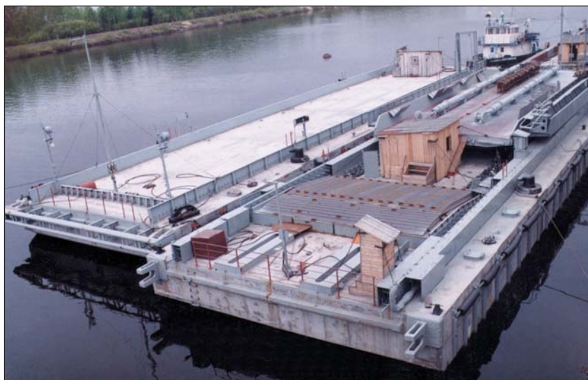
Понтоны тяжелого железобетонного причала, построенного по проекту ЦКБ «Монолит», подготовлены для перегона
