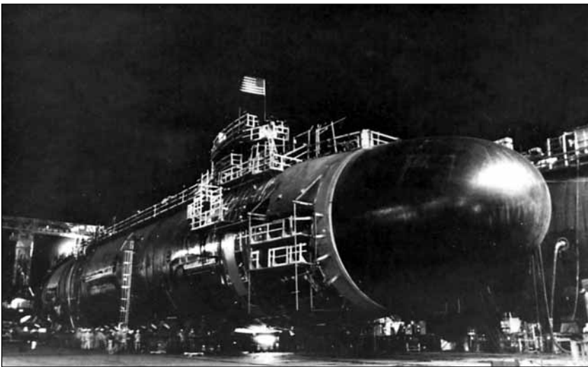
Строительство атомной подводной лодки «Seawolf» на верфи «Electric Boat» в Гротоне
