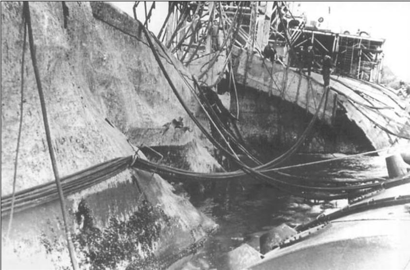
Характер взрыва мины (донный, неконтактный) подтверждается как размером пробоины (около 130—150 м<sup>2</sup>), так и характером повреждений корпуса — листы наружной обшивки загнуты внутрь на глубину до 5 м, что исключает любые версии взрыва внутри корабля
