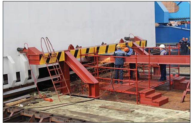
Резка задержника — последней связи ледокола с берегом
