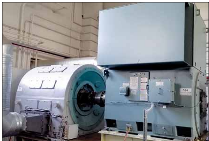
Рис. 18. Высокочастотный (200 Гц) трехфазный главный генератор с приводным электродвигателем
