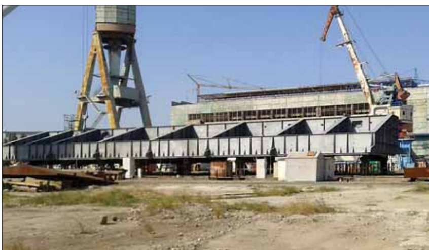
Рис. 5. Общий вид собранного нового затвора на стапельном месте
