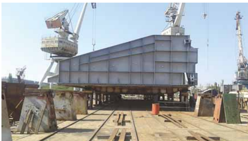
Рис. 4. Сборка затвора на стапельном месте
