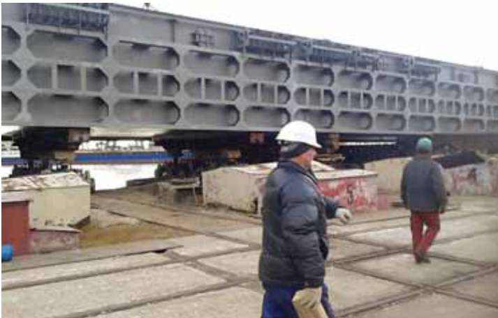
Рис. 7. Установка нового затвора на косяковых тележках слипа
