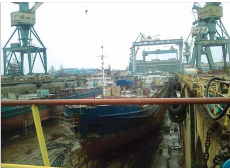
Рис. 1. Вид камеры со стороны основного затвора
