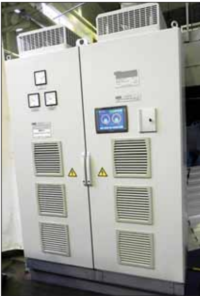
Рис. 7. Щиты управления системы магнитного подвеса ротора гребного электродвигателя
