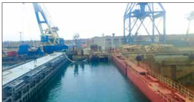
Рис. 9. Заполнение балластных отсеков водой
