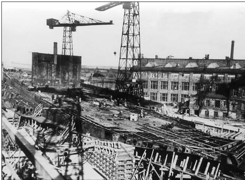
Днищевые секции линейного корабля «Советский Союз» на стапеле завода № 189 (1939 г.)
