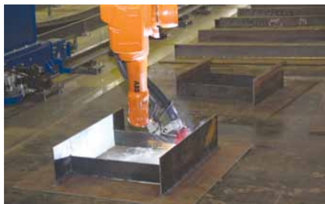
Вертикальная и горизонтальная приварка ребер жесткости к микропанели сварочным роботом
