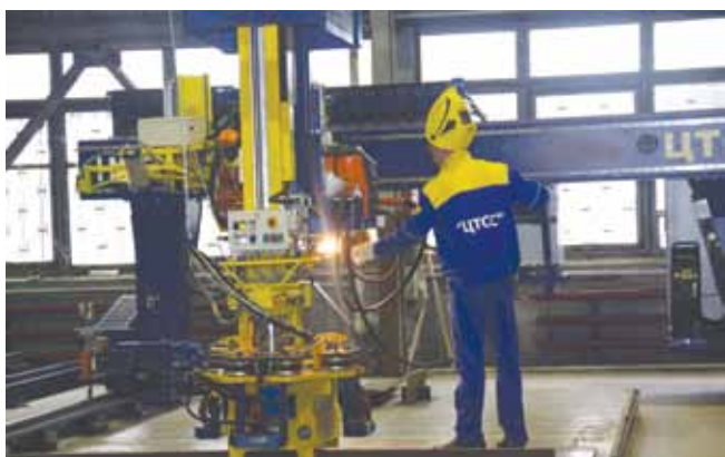
Установка ребра жесткости на микропанель
